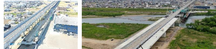
右岸取付道路
