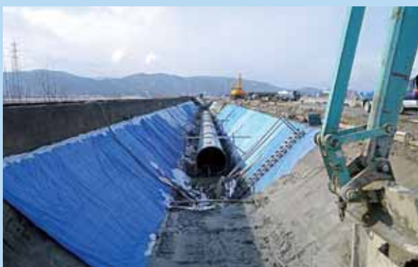
【パイプライン工事の実施状況 河合春近西地区】
