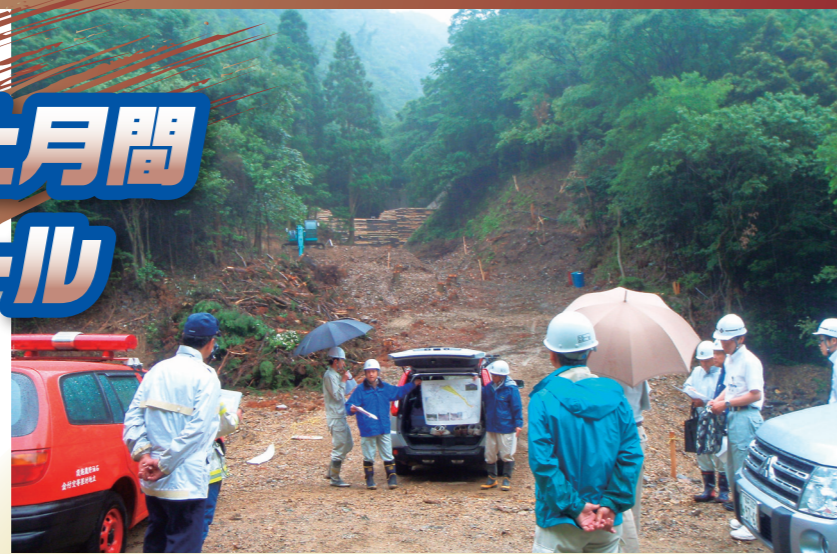
予防治山工事 (福井市袁町)
