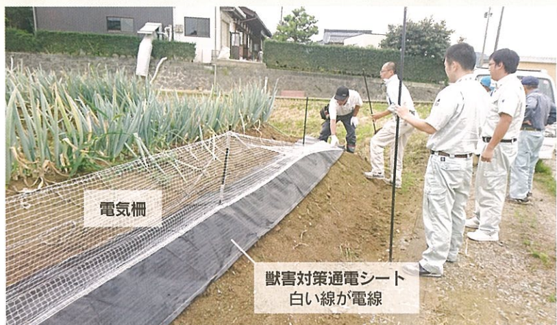
電気柵と獣害対策通電シート設置の様子
