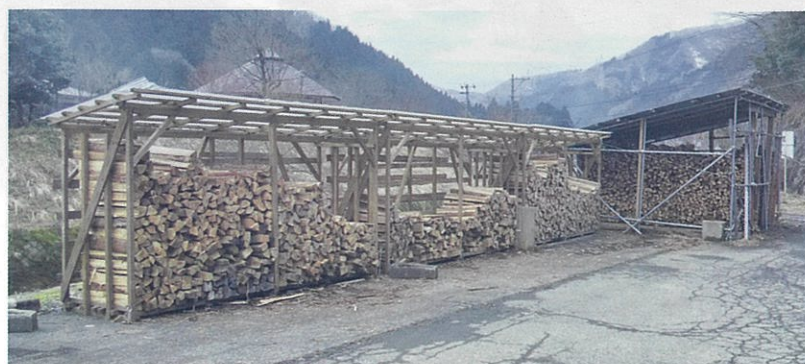
伊自良温泉に導入された薪ボイラと出番を待つ薪
