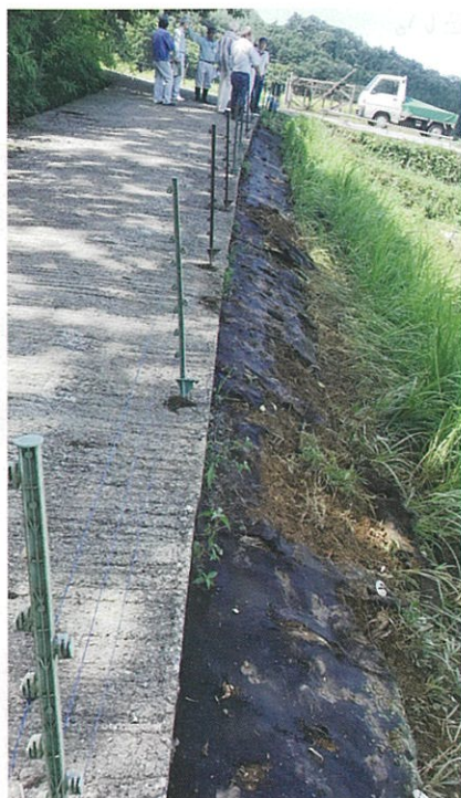
【8月17日(福井市)電気柵の設置状況】 コンクリートの上に設置しているため電圧が低い
