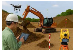
ICT活用工事（イメージ）
