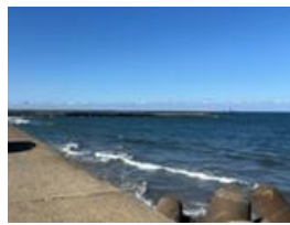
港湾施設点検
