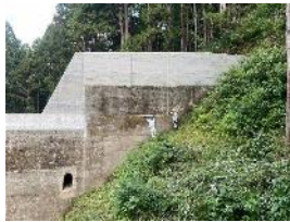
砂防施設点検
