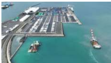
敦賀港鞠山南地区の整備
