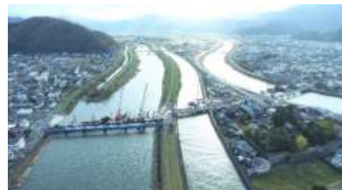
国道162号西津橋、城内橋、大手橋の整備
