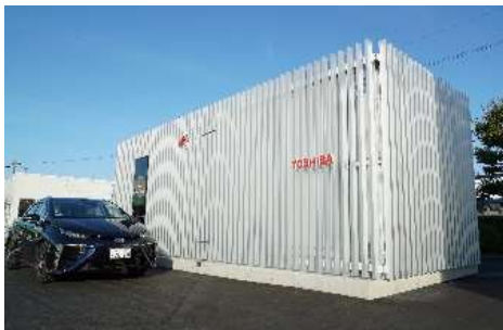
水素ステーション
