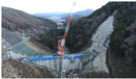
吉野瀬川ダムの整備
