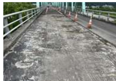
国道416号の橋梁補修（市荒川大橋）
