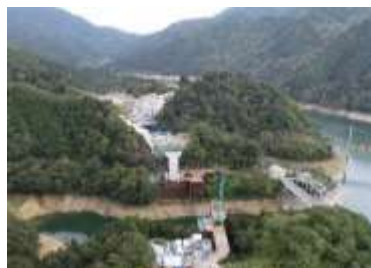
中部縦貫自動車道の整備 （新子馬巣谷橋（仮称））
