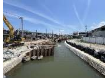
底喰川の改修（拡幅）
