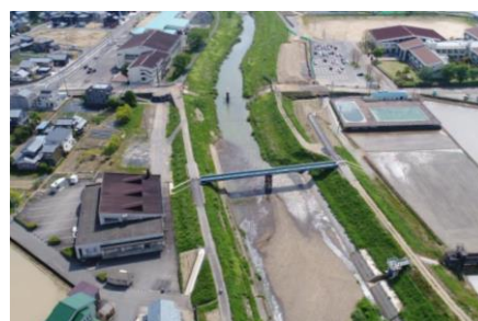
河川拡幅工事（天王川）
