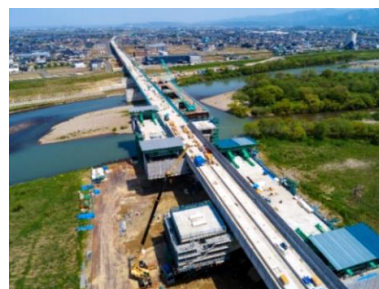
整備が進む北陸新幹線 (九頭竜川橋りょう)
