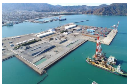
敦賀港鞠山南地区の整備
