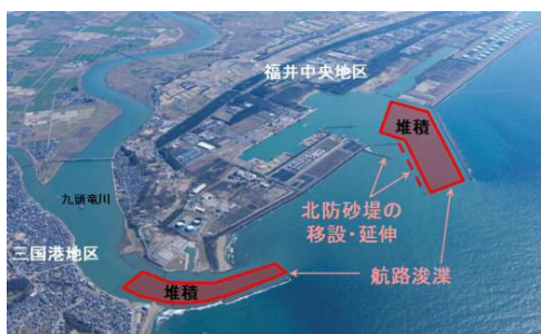
福井港北防砂堤延伸工事
