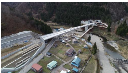
中部縦貫自動車道 九頭竜川橋（仮称）
