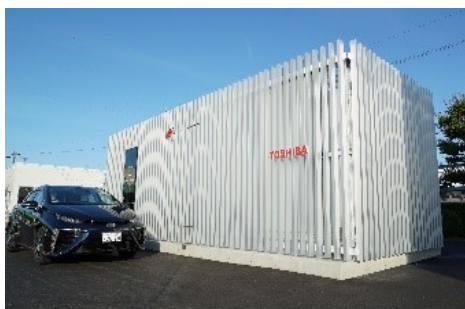
水素ステーション
