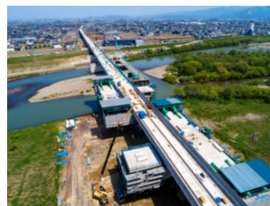
整備が進む北陸新幹線 (九頭竜川橋梁)
