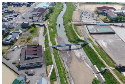
河川拡幅工事（天王川）
