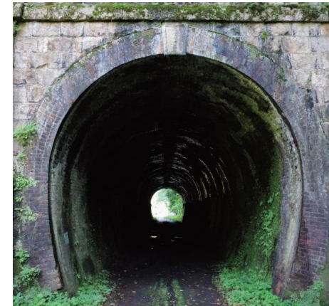
旧北陸線トンネル
