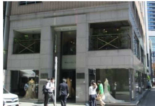
店舗正面入口
