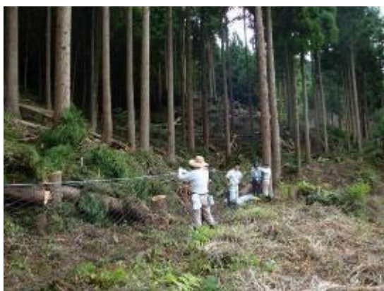
図 2 3 防護柵周辺の藪の刈り払い事例
