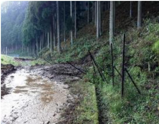
図 2 9 金網柵が破損し、 侵入可能になっている
