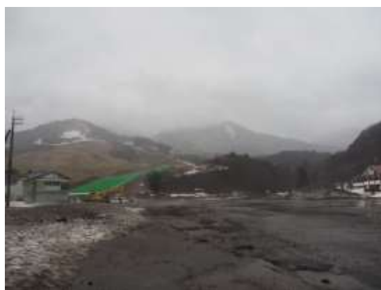
＜前面のアスファルト舗装＞
