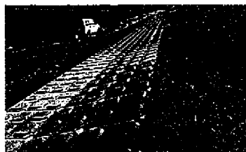
堤防の裏法補強工事(日野川)
