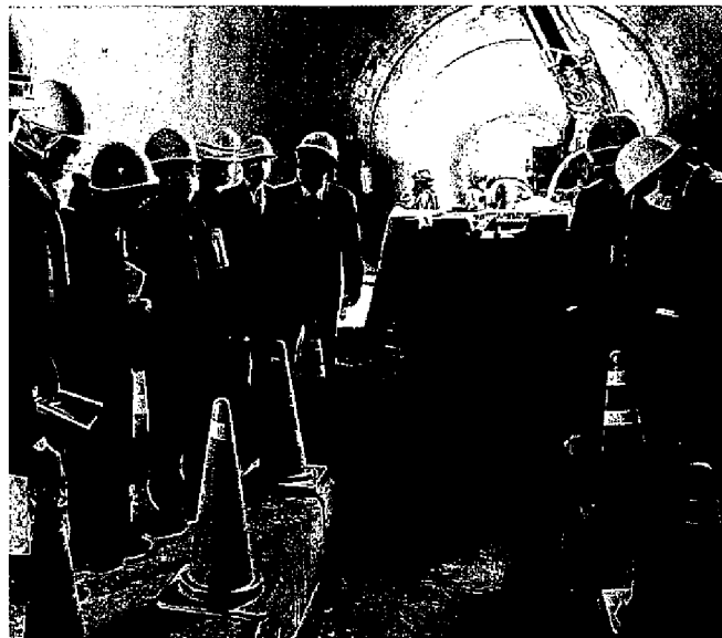
新幹線議員連盟による北陸新幹線加賀トンネル視察
