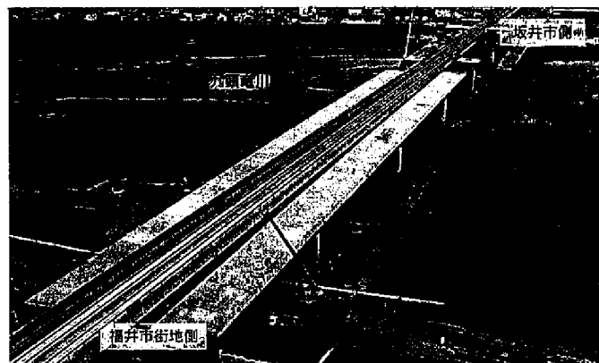
新九頭竜橋(仮称)左岸側 架設完了
