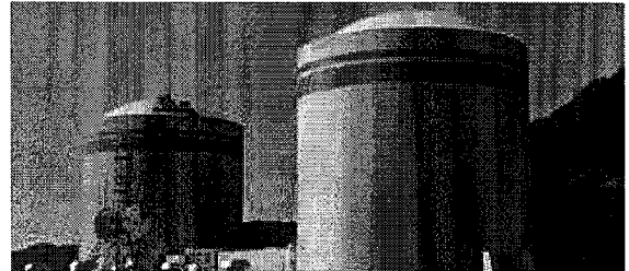
高浜発電所1、2号機
