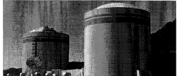
高浜発電所1、2号機
