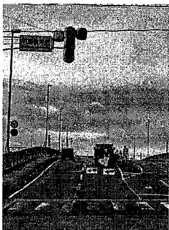
改修工事が始まった 新明里橋
