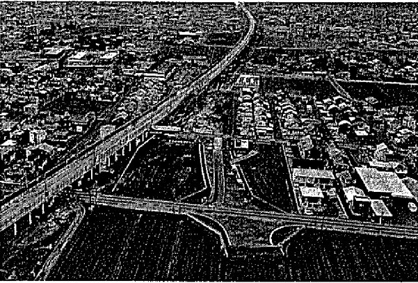
建設中の福井森田丸岡線(坂井市春江町寄安～中筋付近) 令和3年11月撮影
