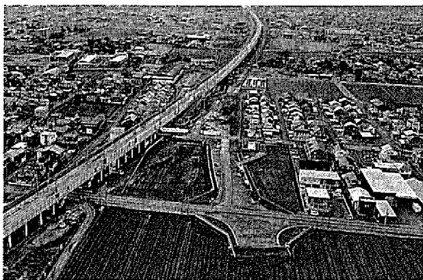
建設中の福井森田丸岡線(坂井市春江町寄安～中筋付近) 令和3年11月撮影
