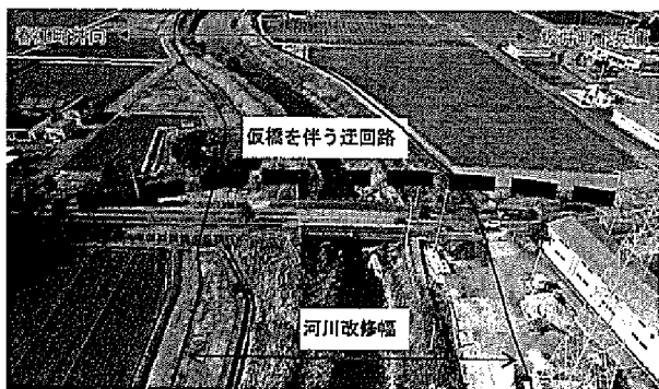
河道拡幅工事 芦原街道(新橋) 令和3年11月撮影
