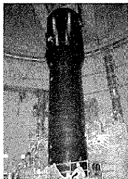
蒸気発生器取り替えの様子
