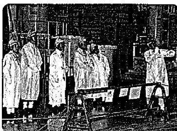
もんじゅの解体現場を視察
