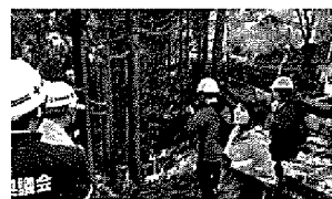
6人チームで倒した間伐木材をスイングヤーダという機械のワイヤーで引き上げ林道脇に集積する作業
