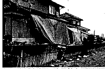
滝地区の家屋被害
