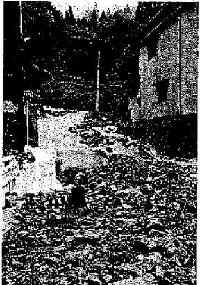
土砂や瓦礫が流入してアスファルトがめくれ上がり、大きな被害。13日午前7時00分ごろ、勝山市野向町北の畝見川(畝見川支流)で撮影。
