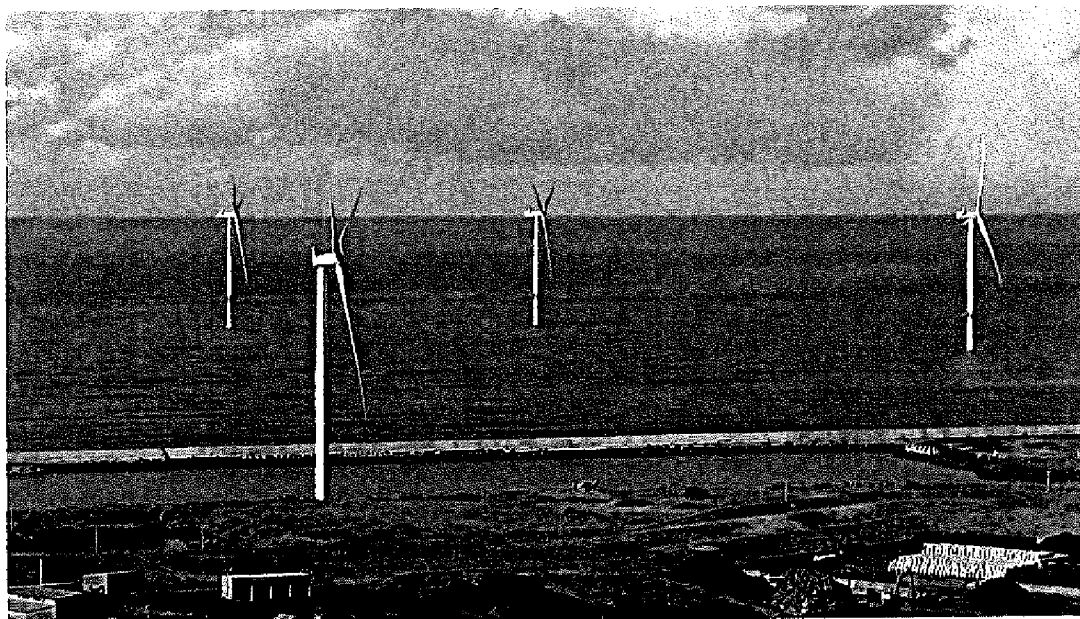
秋田港の風力発電施設。手前が地上。下部が黄色い奥の物が洋上施設。
