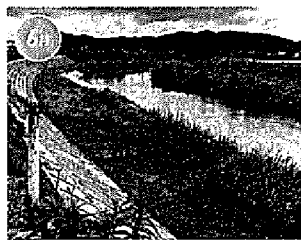
竹田川護岸壁の現場確認
