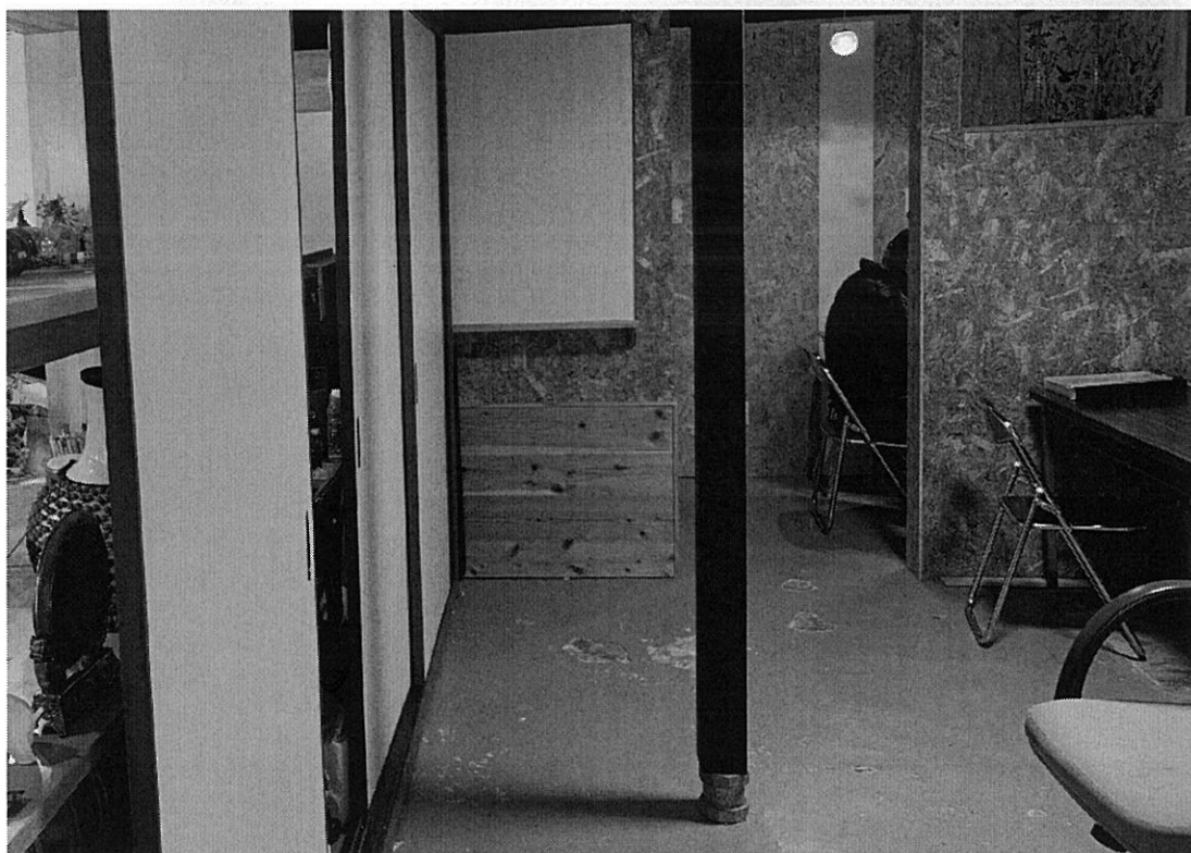
パーティション左側は他店舗、同右側が事務所
