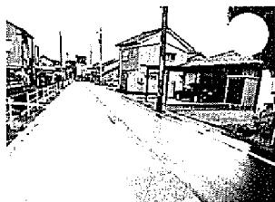
春江町江留上旭 県道160号 路面改修
