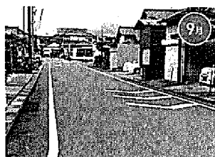
春江町境 事故多発注意喚起 路面標示 整備
