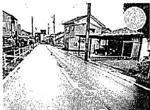
春江町江留上旭 県道160号 路面改修
