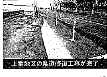
12月 上番地区の県道修復工事が完了
