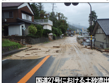
国道27号における土砂流出
