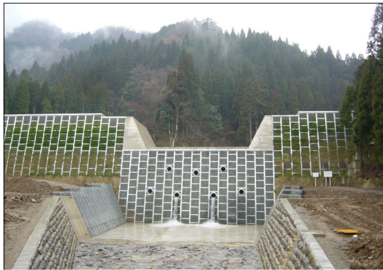
蔵作川砂防堰堤 (平成20年9月30日完成)
