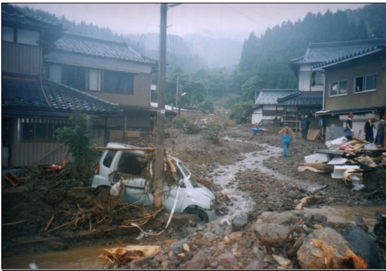
福井市蔵作町（蔵作川）被害状況 (平成16年7月19日)
