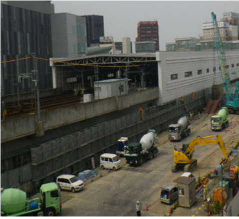
北陸新幹線工事
