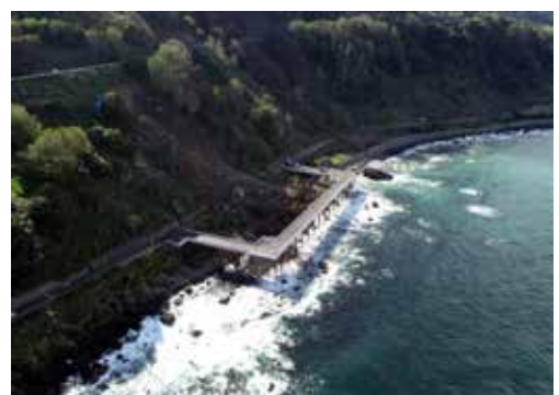
国道305号(福井市居倉町)の復旧工事
