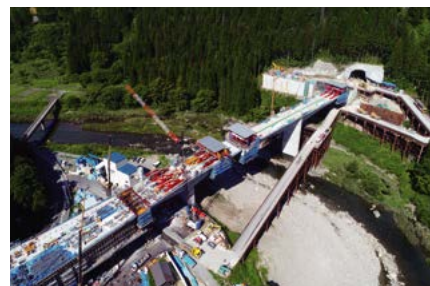
中部縦貫自動車道 工事状況
