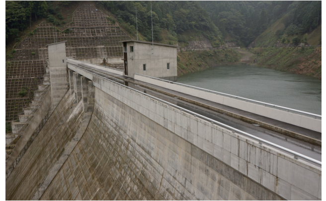
県管理の河内川ダム
