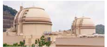
大飯発電所3、4号機
