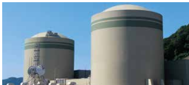
高浜発電所1、2号機
