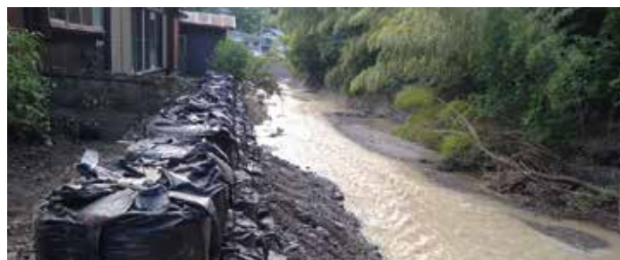
「復旧工事後の状況（南越前町）」
