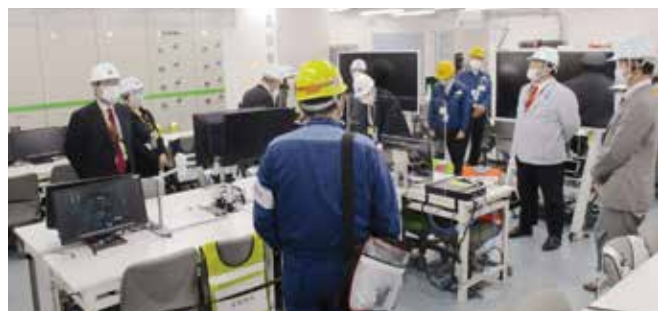
関西電力(株)美浜発電所の現場視察
