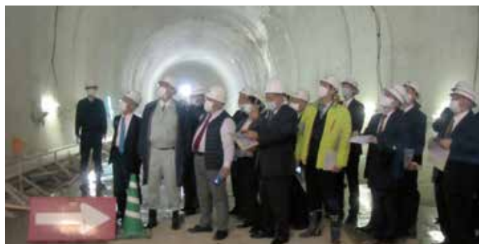
加賀トンネルの調査（令和2年11月6日）
