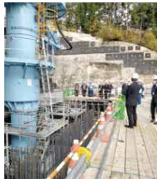
委員会による中部縦貫自動車道大野油坂道路の工事現場視察の様子
