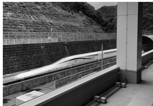
走行試験の様子
