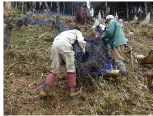
▲防護柵の撤去
