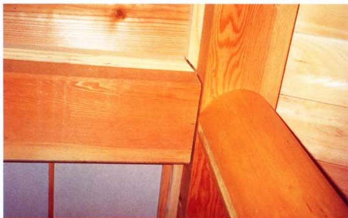
乾燥の不十分な木材を使うことによって、クロスのひび割れ、きしみ、床なり、仕口の隙間などが発生しています
