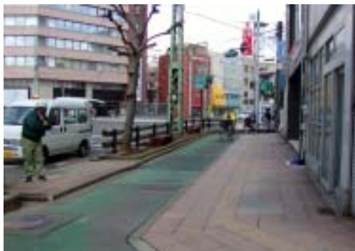
写真1 設置したガードレール 〔福井市 大名町交差点〕
