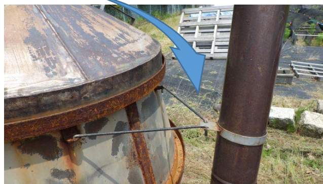
金具による煙突の固定
