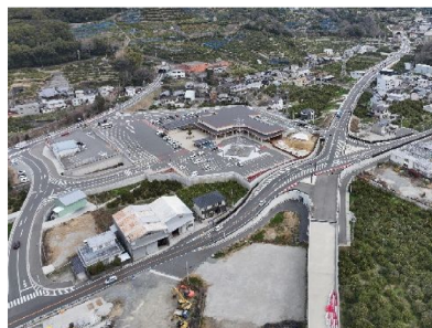
道の駅「海南サクアス」
