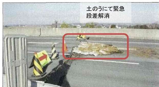
橋梁段差の解消
